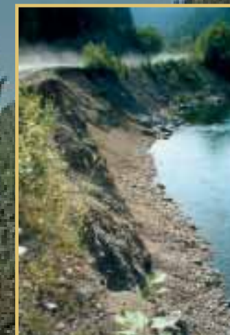
Érosion des berges
